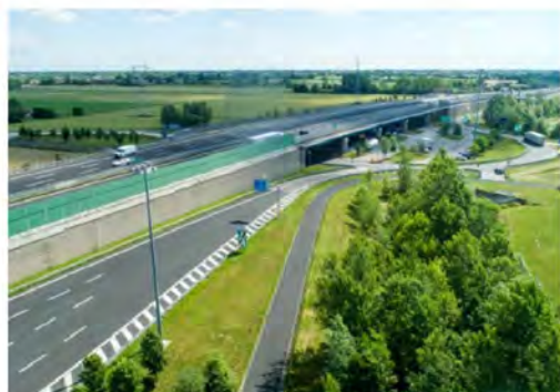
Green Highway Infrastructure, A22 Brennero - Fonte: Autostrada del Brennero SpA, 2020
