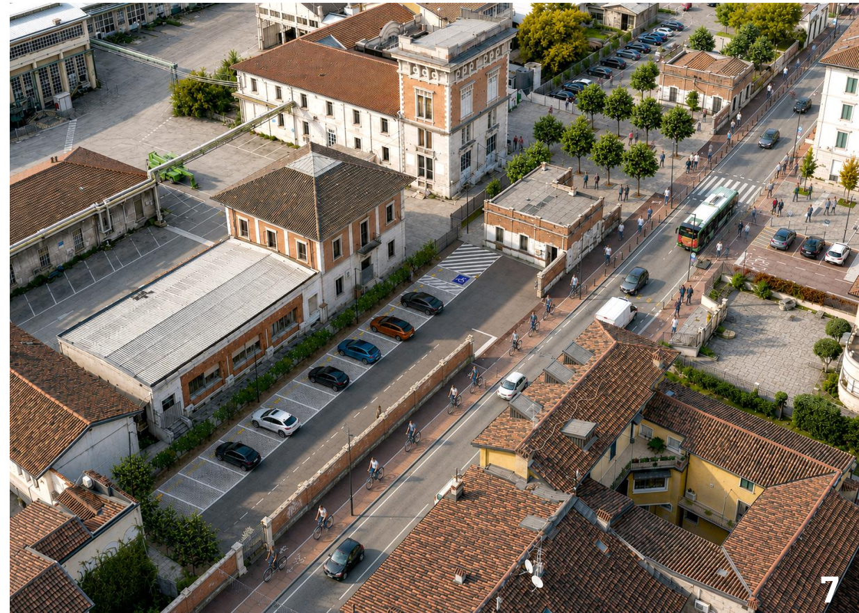
VISTA DA NORD-EST DELL'AREA DI INTERVENTO
