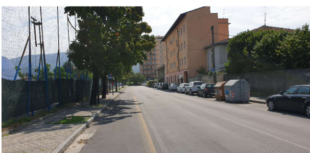
7. Corsia ciclabile bidirezionale fuori norma perché senza separazione fisica.
