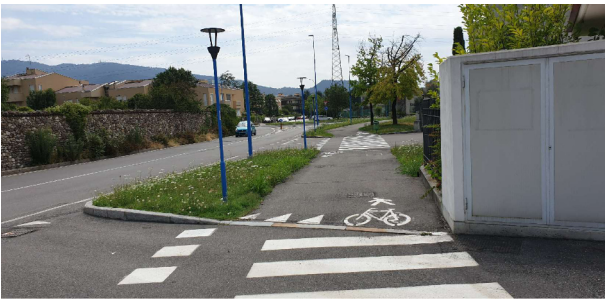
1. Marciapiede ciclopedonale di via Stretta con errori nella segnaletica orizzontale.
