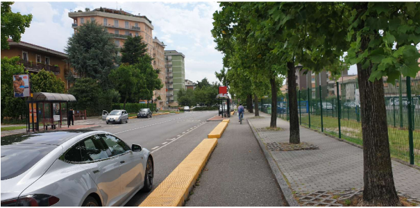
7. Pista ciclabile monodirezionale separata.
