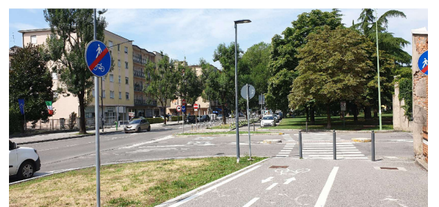
9. Corsia ciclabile bidirezionale contigua al marciapiede che si interrompe in corrispondenza dell'accesso all'Ospedale.
