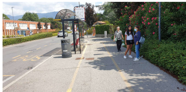
5. Corsia ciclabile monodirezionale contigua al marciapiede e conflitto con i pedoni.
