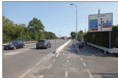
6. Cavalcavia su via Volturmo per superare Mella e Tangenziale Ovest, separato con mini-newjersey in cls.
