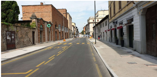
3. Il cantiere di via Milano.
