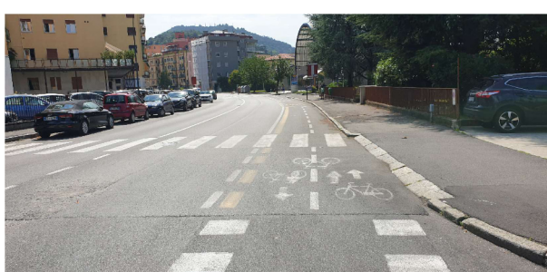
8. Corsia ciclabile bidirezionale fuori norma perché senza separazione fisica.
