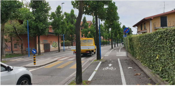
5. Pavimentazione disconnessa e conflitti laterali.
