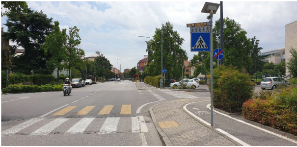
8. Carreggiata ampia ed errori nella segnaletica verticale (fine pista).
