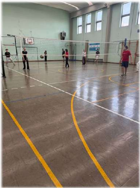
PAVIMENTAZIONE ATTUALE INTERNA PALESTRA
