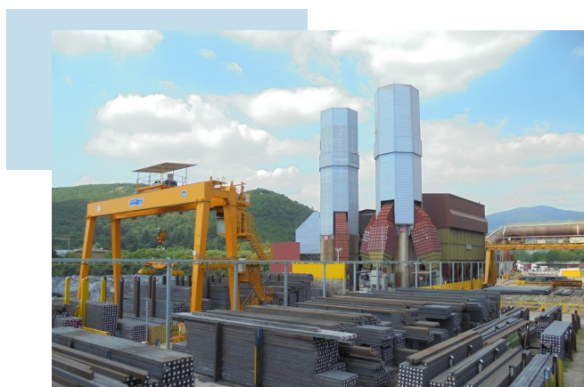
Impianto abbattimento fumi acciaieria
