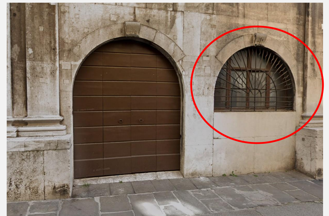
Finestra della facciata ovest su Corsetto S. Agata interessata dall'intervento
