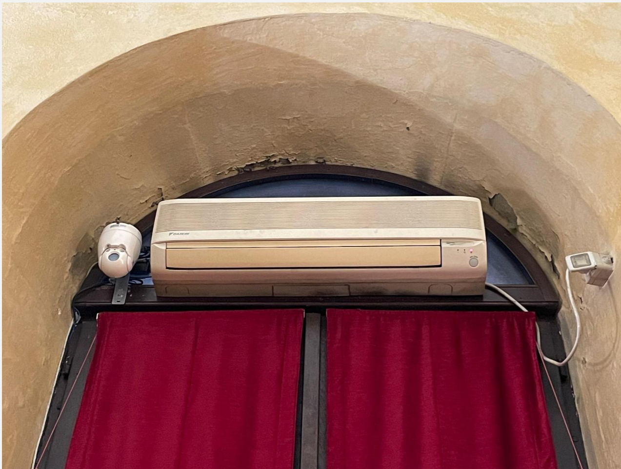
Impianto di climatizzazione fissato alle lunette dei serramenti Unità interne ed esterne
