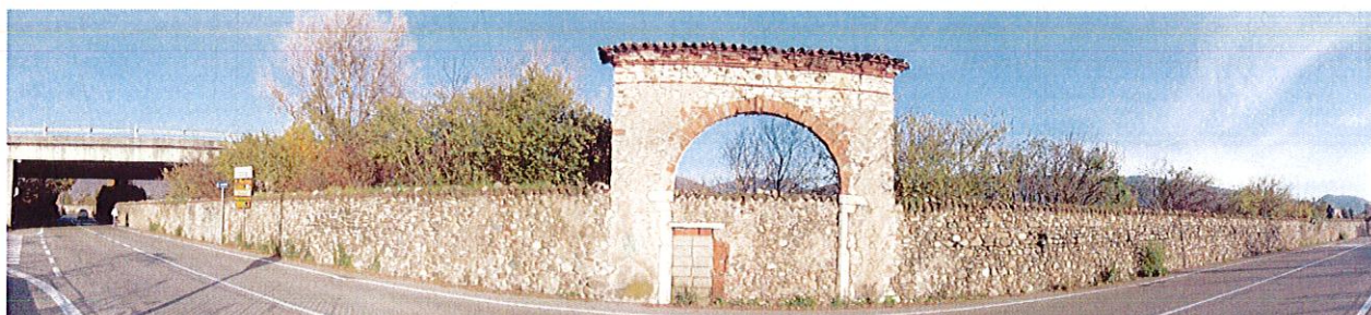
Fotografia muro storico
