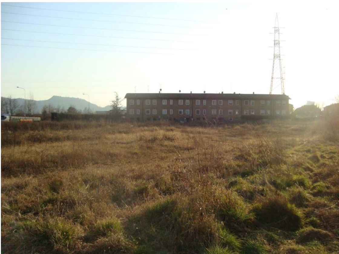
vista 4 (vista del confine sud dell'area di intervento)
