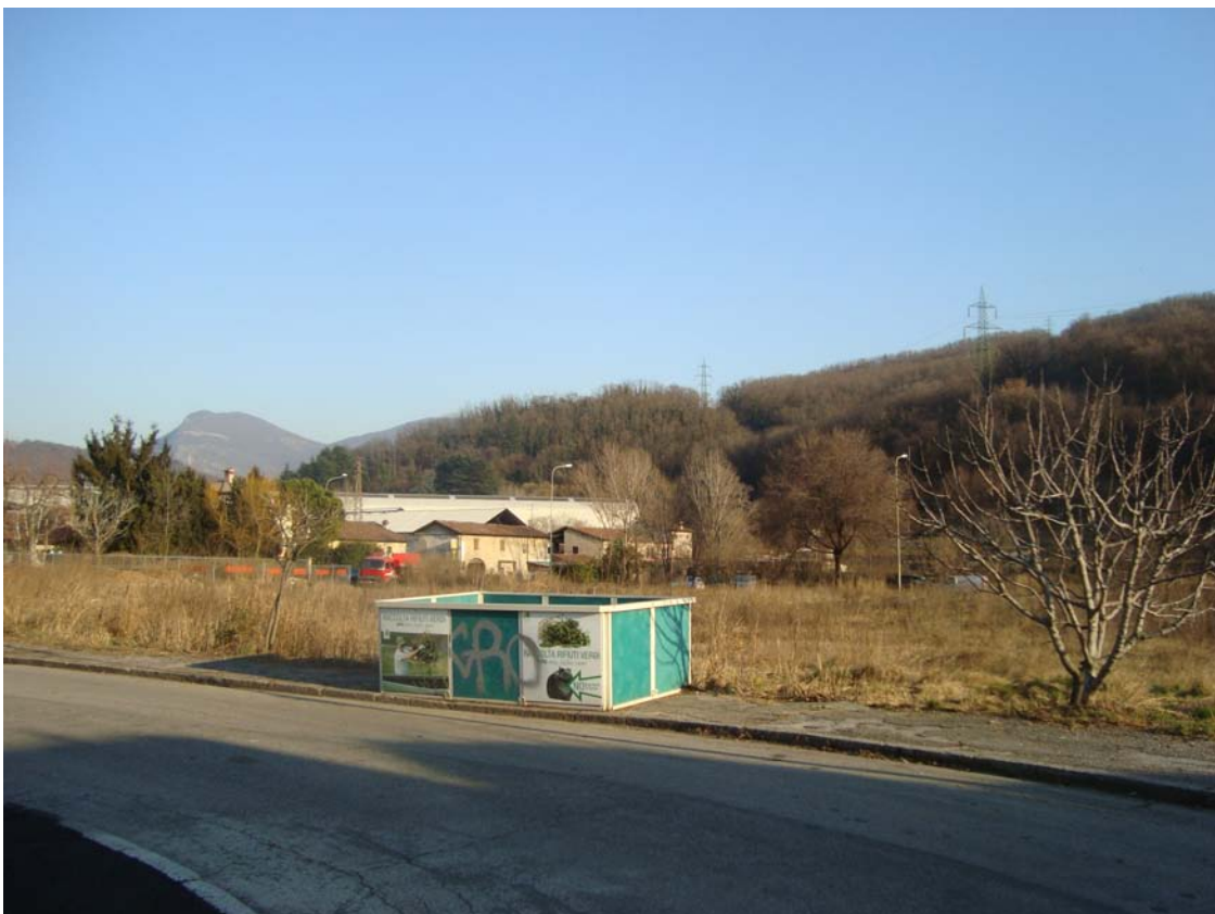
vista 10 (vista dell'area di intervento da sud)
