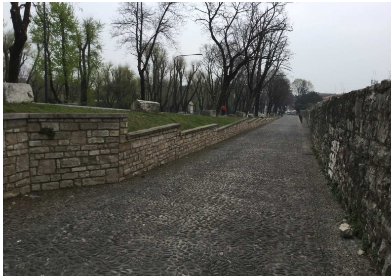
Foto 01: Inquadramento delle aiuole fronte ingresso Istituto Artigianelli presso via B. Avogadro, 23
