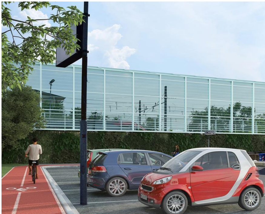
Figura 4 – Barriera acustica tratto urbano di Brescia – trasparente su muro
