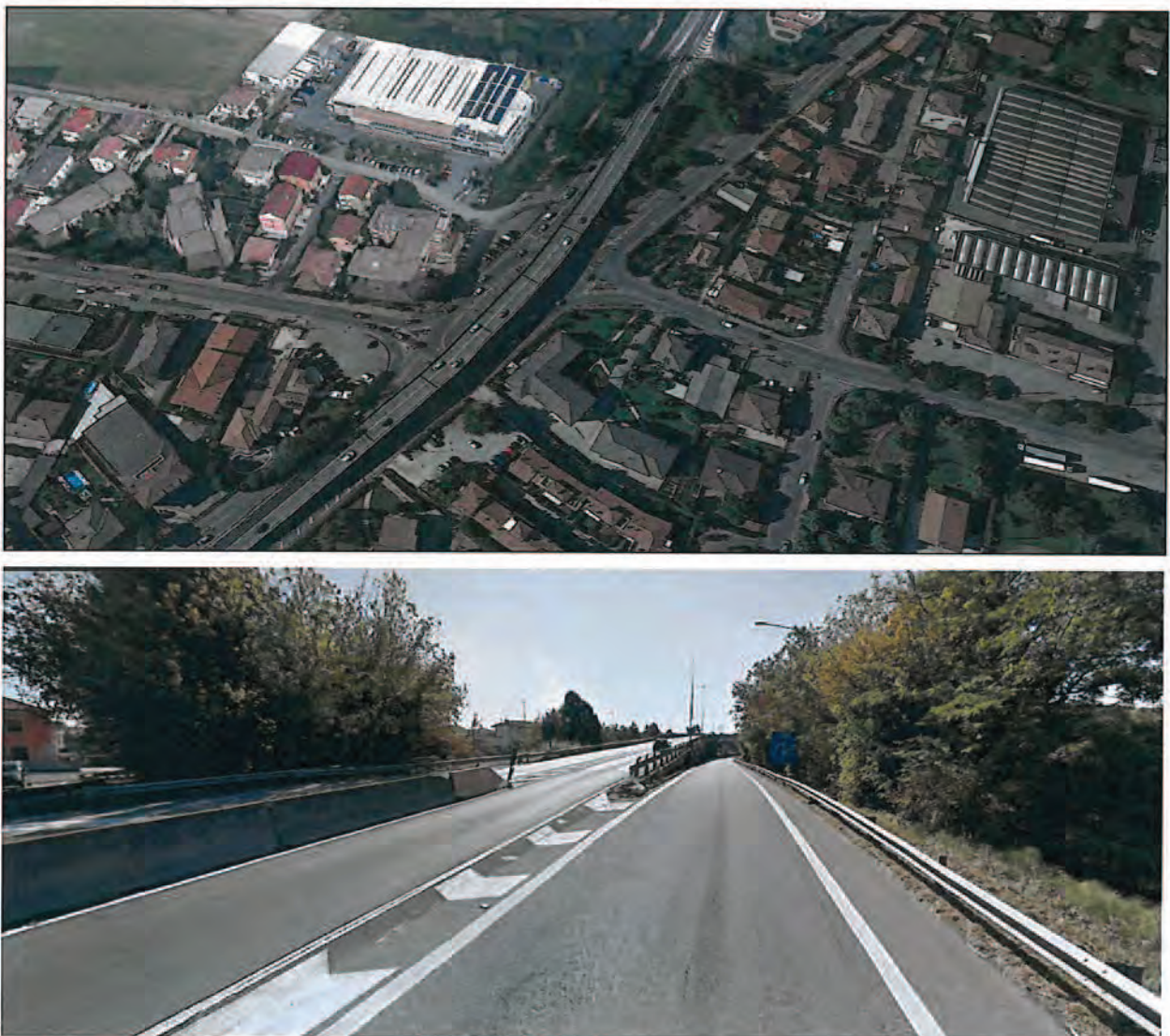
Figura 6: ortofoto e vista dal cavalcavia della tangenziale Ovest in direzione sud
