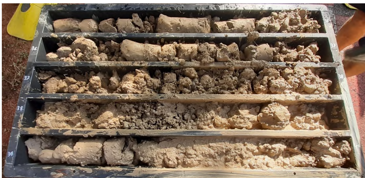
Immagine delle cassette catalogatrici – Sondaggio S2 da -35 a -40m
