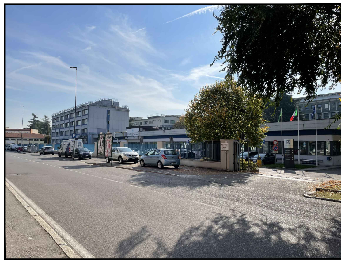
01 - Stato di fatto: Vista da ingresso carrabile su Via Bianchi
