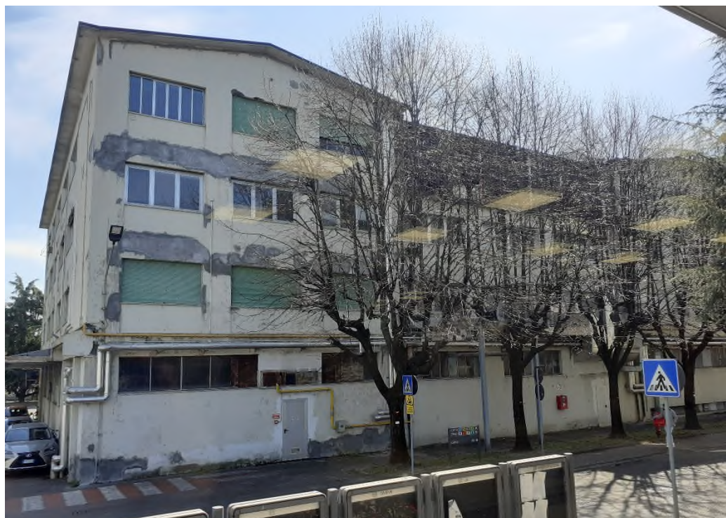
Vista da Nord-Ovest - Retro dell'edificio esistente
