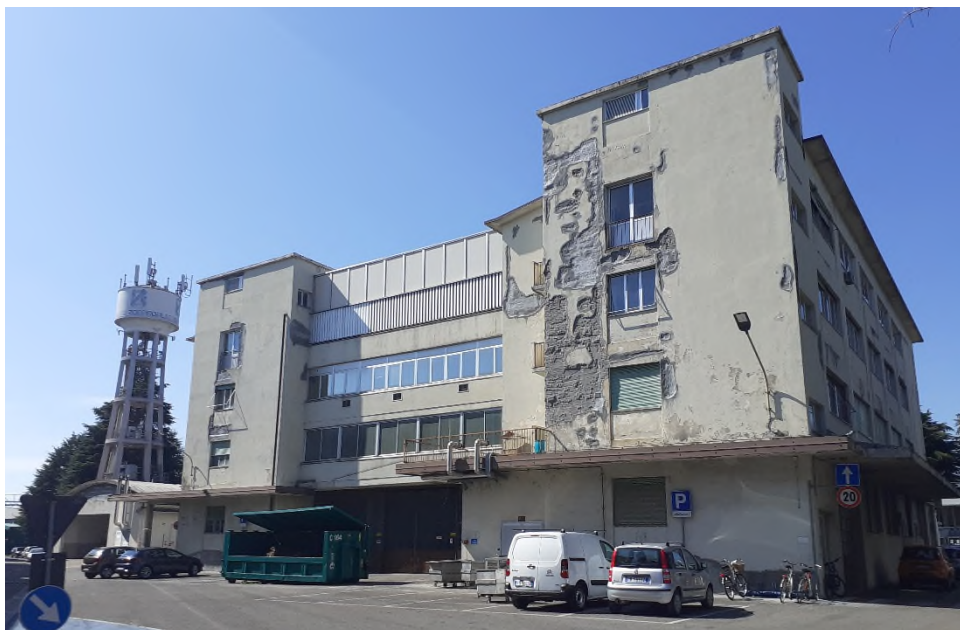
Vista da Nord-Est - L'ingresso principale dell'edificio esistente
