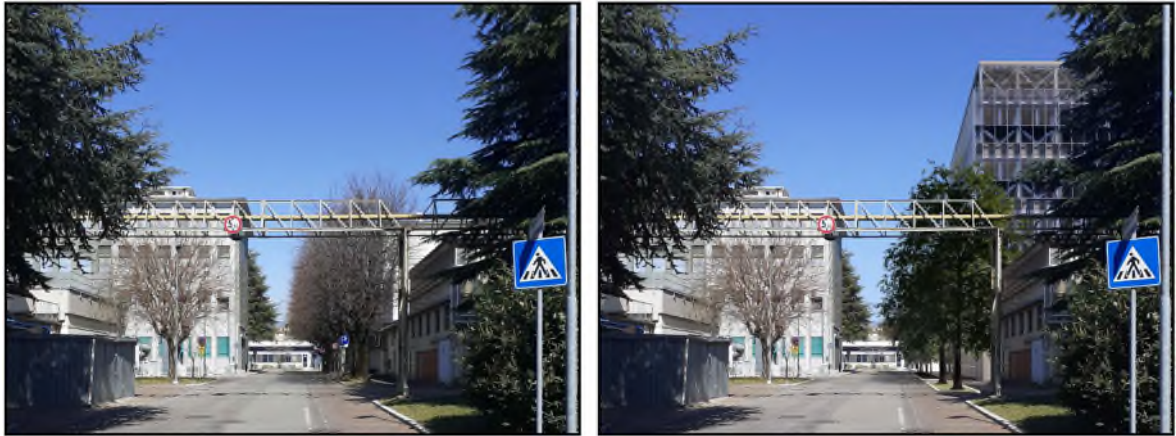
Vista dell'edificio esistente e del fotoinserimento da via una via interna all'Istituto
