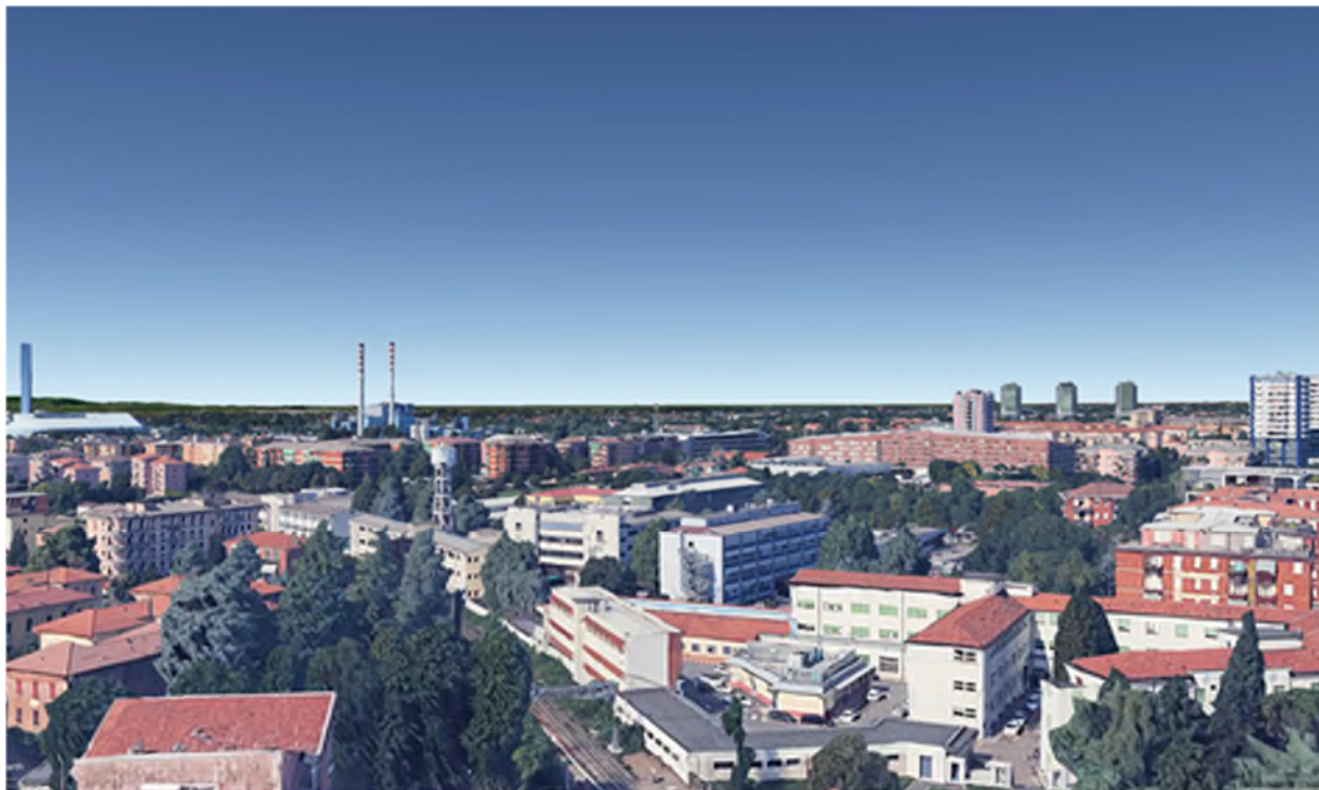
Vista dall'alto dell'Istituto da Google Earth: Vista da Nord-Est
