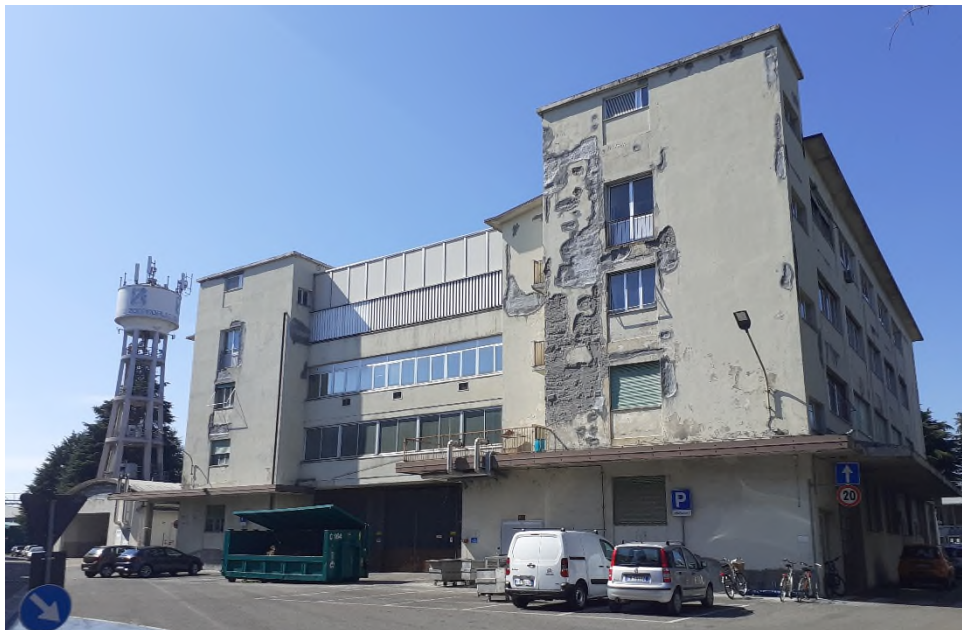
Vista da Nord-Est - L'ingresso principale dell'edificio esistente
