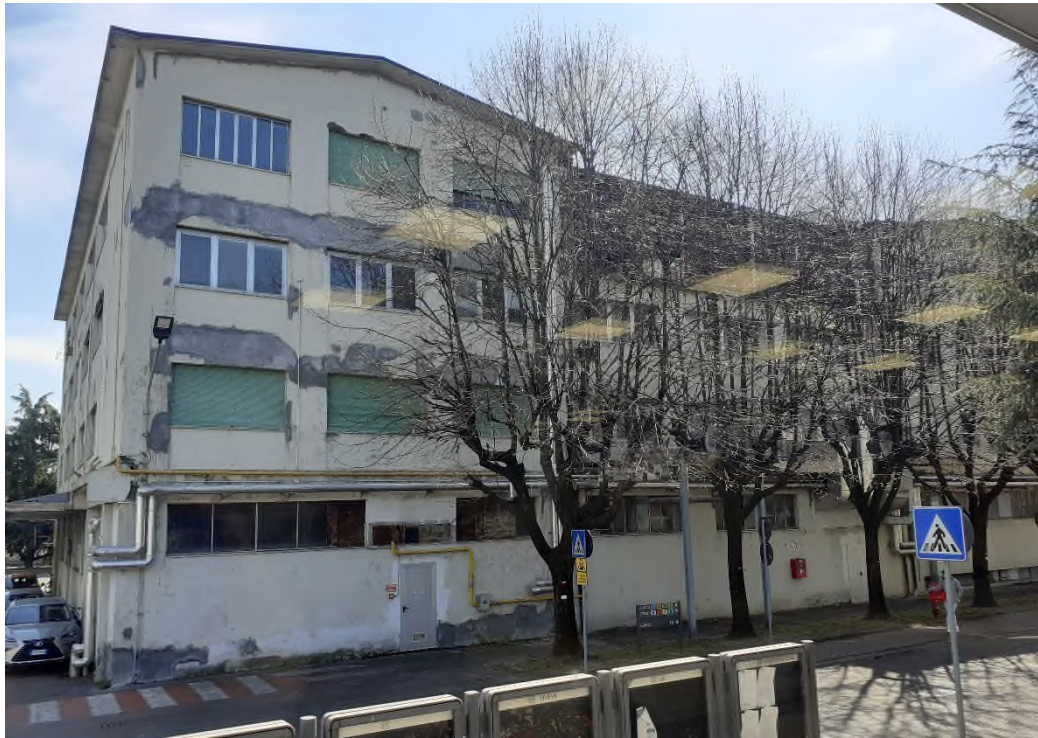
Vista da Nord-Ovest - Retro dell'edificio esistente
