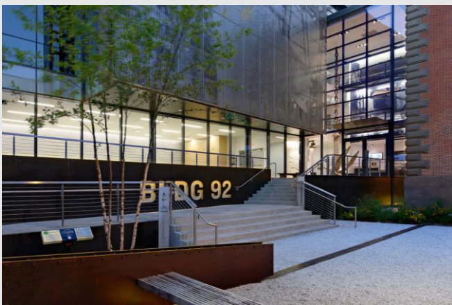
BLDG 92 – New York
