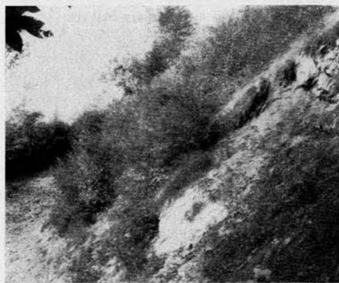
Fig. 1 - Bivio del Santellone di Dosso: a sinistra la vecchia carreggiata, a destra parte del fronte di frana
