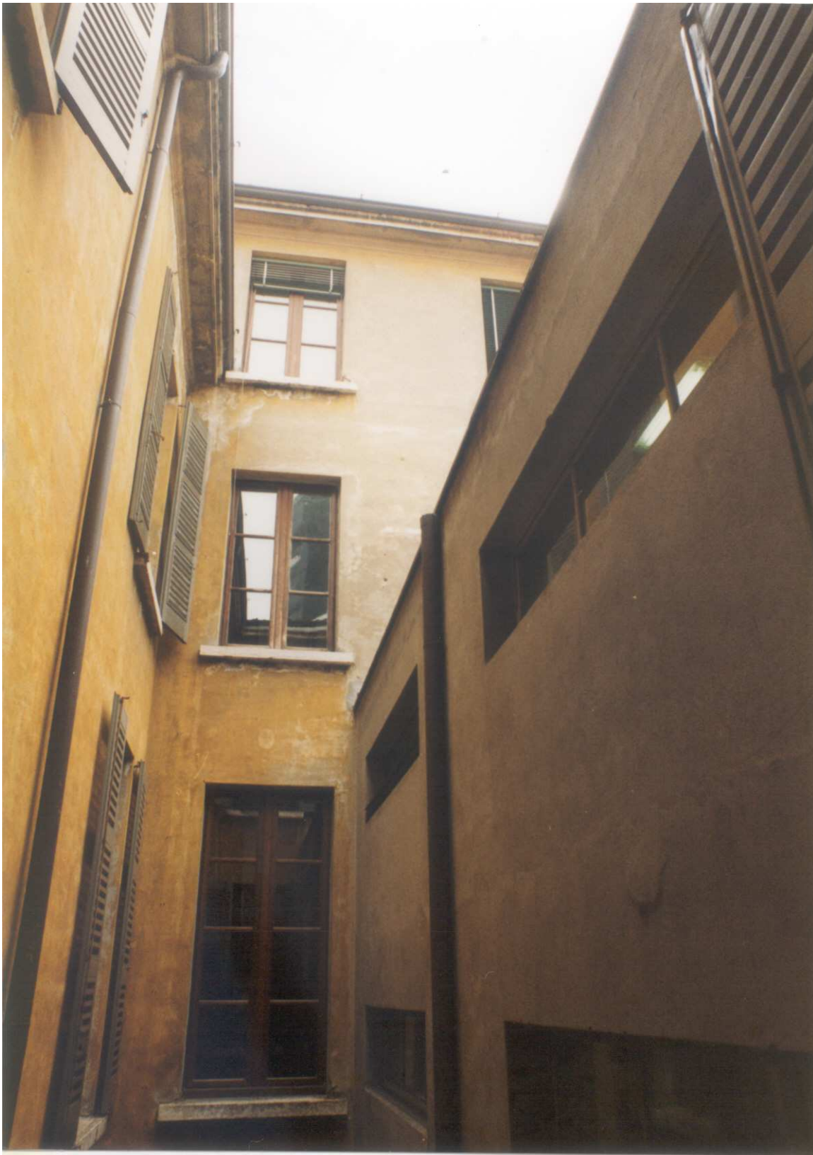
2. Visione dal piano primo dell'ex cortiletto interno oggi obliterato dalla superfetazione del deposito librario. Volume realizzato agli inizi degli anni '70 a fronte dell'emergenza spazi. Il progetto ne prevede l'eliminazione e la riqualificazione dell'intero sito.
